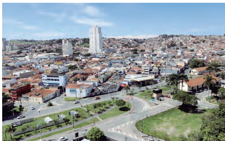
Colocação de tapumes na praça do Pátio dos Trilhos para canteiro de obras do “Renova Centro”
